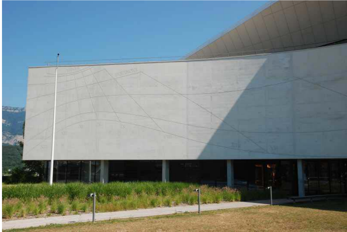
Le Bourget-du-Lac, Institut National de l'Energie Solaire, double cadran à réflexion, réalisé par Denis Savoie, 2014
